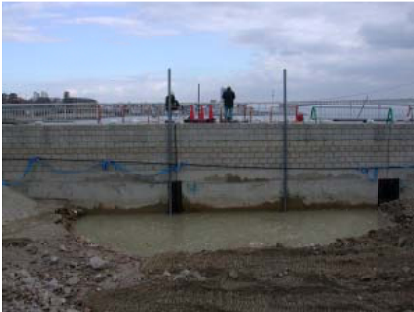
埋戻し前の状況(観測前)
