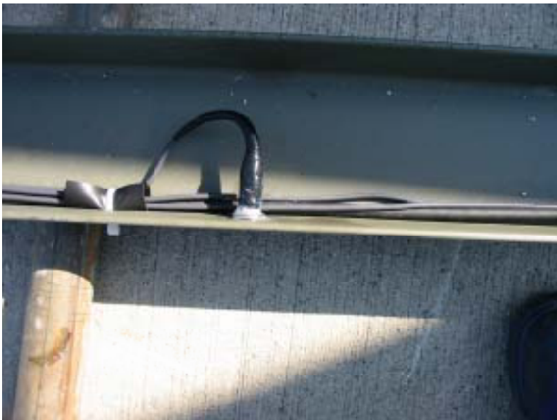
波圧計の取付架台 への取付状況
