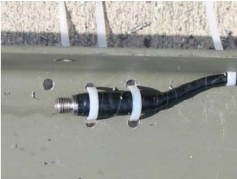
水位計の架台 への取付状況
