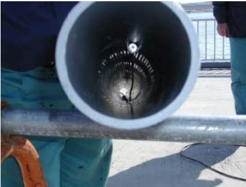
ストレーナー内への 水位計の取付状況
