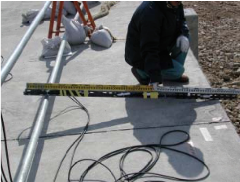
間隙水圧計の 架台への取付状況
