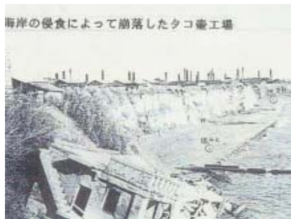
写真-1 侵食によって崩落した工場(江井ヶ島海岸)
