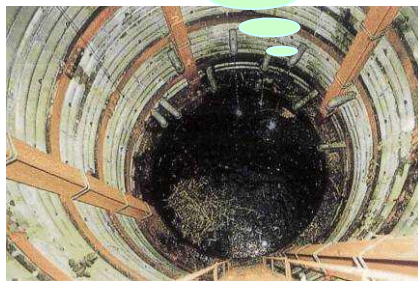
集水井を上からのぞいた様子
