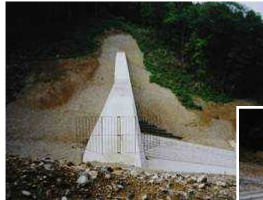
西之貝戸川2号砂防えん堤
