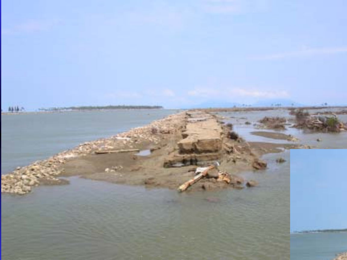
河川堤防の破堤、流失
