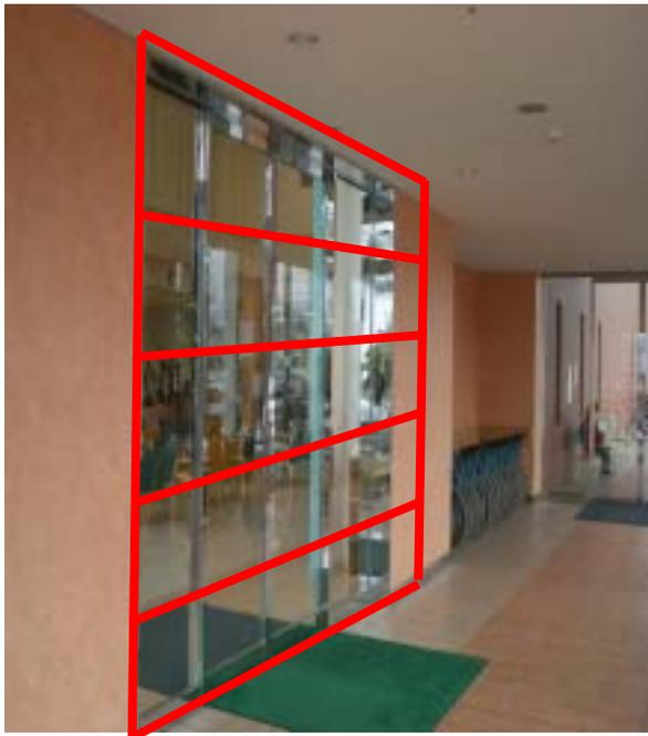
写真 - 8 脱着式防水パネル
