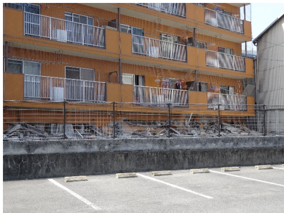
図 8.4.2 4月16日の本震後の状況 (1階の店舗が崩壊した集合住宅)
