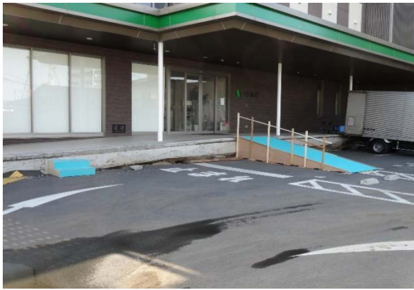
図 8.4.11 4月16日の本震後の状況 (病院の玄関に液状化による大きな段差)
