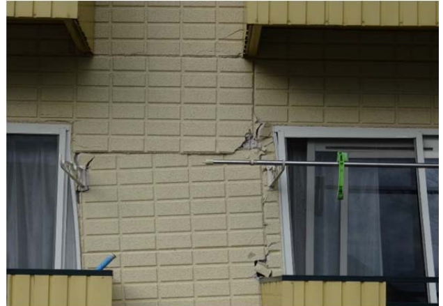
図 8.3.2 4月16日の本震後の南阿蘇村の被害 （大きく変形したアパートの壁）
