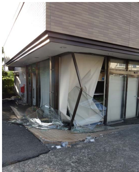
図 8.4.12 4月16日の本震後の状況 (液状化による変形で損傷した店舗)
