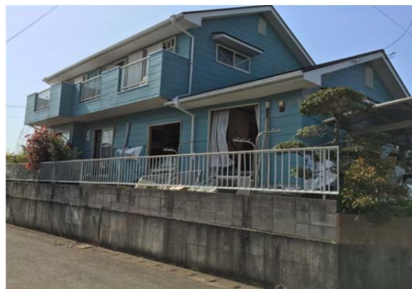
図 8.2.4 4月14日の前震後の状況 (築20年の新耐震の住宅)
