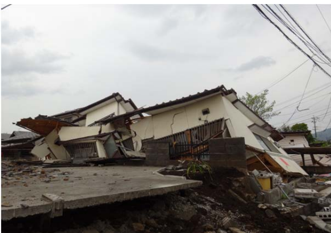
図 8.2.2 4月16日の地震後の益城町の被害 (隣家との境界がわからないほどの被害)
