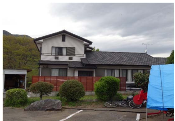
図 8.3.4 4月16日の本震後の状況 （外観上は無被害に見える新しい住宅）
