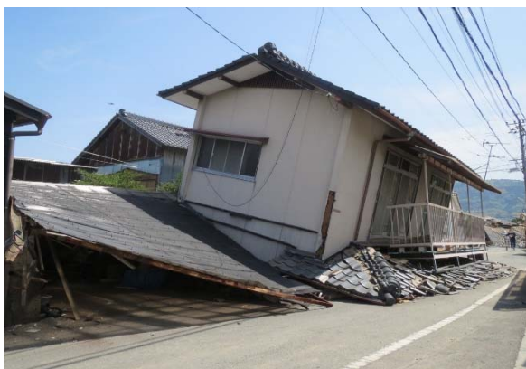
図 8.1.2 4月14日の前震後の益城町の被害 (老朽化した木造住宅の被害)
