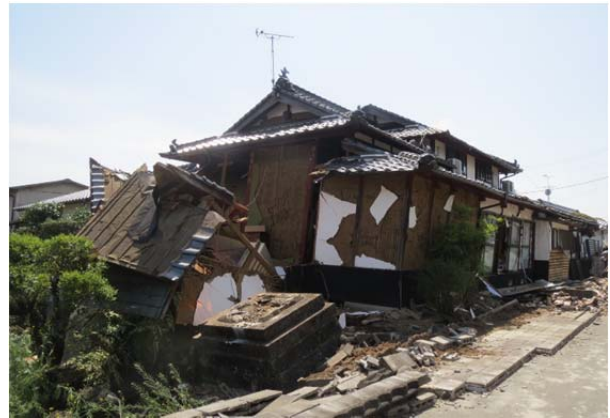
図 8.1.3 4月14日の前震後の益城町の被害 (老朽化した木造住宅の被害)
