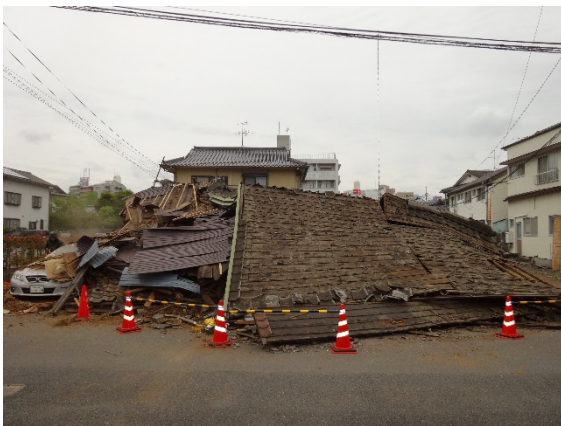
図 8.4.7 4月16日の本震後の状況 (熊本市内の古い木造住宅)
