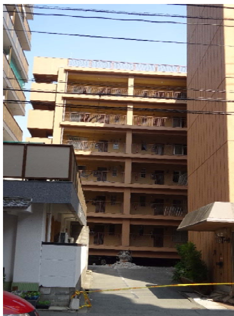
図 8.4.3 4月16日の本震後の状況 (1階の駐車場が崩壊した集合住宅)
