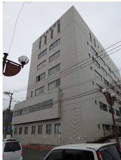
図 8.4.14 4月16日の本震後の状況 (被害が大きく機能不全に陥った病院)
