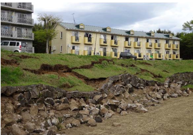
図 8.3.1 4月16日の本震後の南阿蘇村の被害 （地表地震断層が建物直下で動いた）
