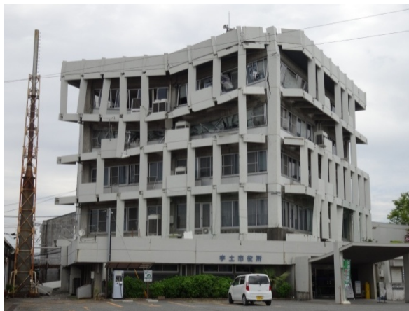
図 8.4.13 4月16日の本震後の状況 (被害が大きく機能不全に陥った市庁舎)
