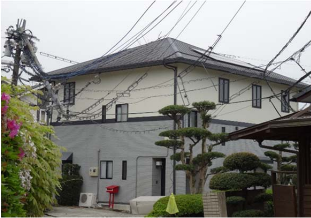
図 8.2.6 4月16日の本震後の状況 （外観上は無被害に見える新しい住宅）
