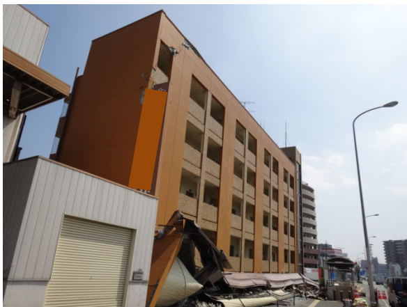
図 8.4.1 4月16日の本震後の状況 (1階の店舗が崩壊した集合住宅)
