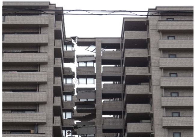
図 8.4.8 4月16日の本震後の状況 (集合住宅の渡り廊下の損傷)
