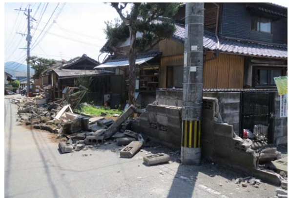
図 8.1.4 4月14日の前震後の益城町の被害 (ブロック塀の倒壊)
