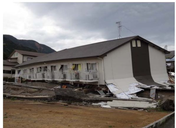
図 8.3.3 4月16日の本震後の南阿蘇村の被害 （一階が完全に崩壊したアパート）
