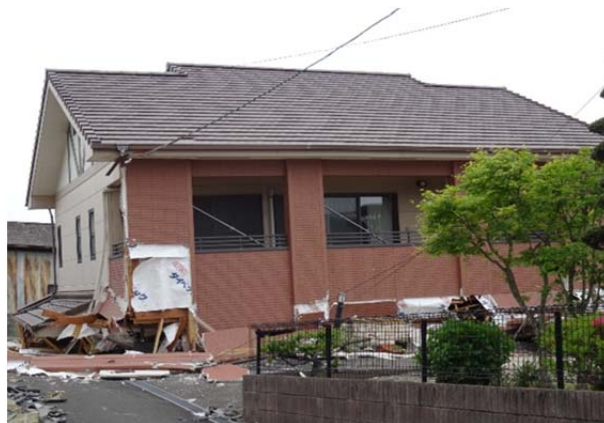
図 8.2.3 4月16日の本震後の状況 (1階が倒壊した住宅)
