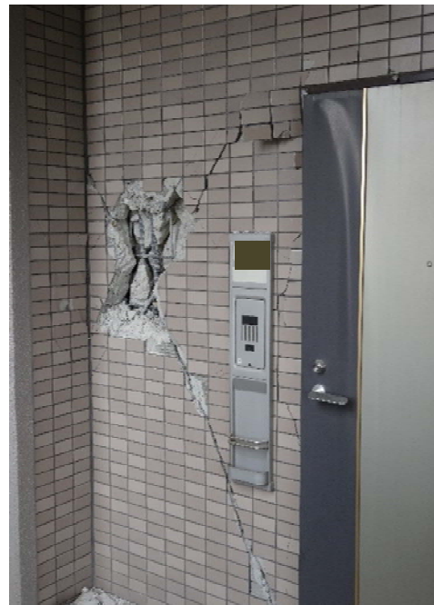
図 8.4.9 4月16日の本震後の状況 (集合住宅の廊下の壁と扉の損傷)
