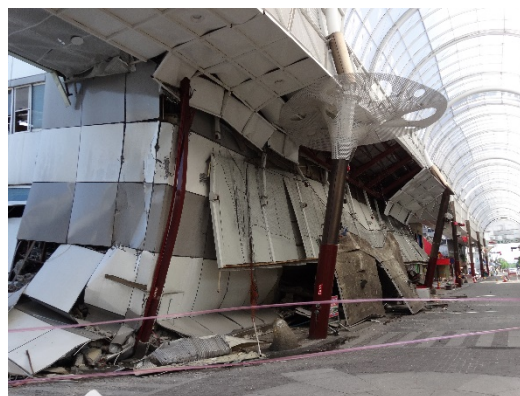
図 8.4.5 4月16日の本震後の状況 (アーケード内に倒壊した建物)
