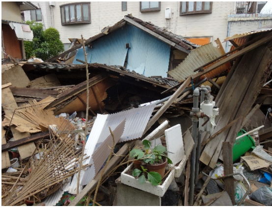
図 8.4.6 4月16日の本震後の状況 (熊本市内の古い木造住宅)
