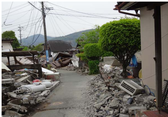
図 8.2.1 4月16日の地震後の益城町の被害 (辺り一面が連続的に被災している様子)
