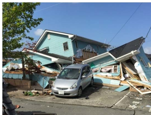
図 8.2.5 4月16日の本震後の状況 (築20年の新耐震の住宅)
