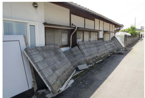
図 8.1.5 4月14日の前震後の益城町の被害 (ブロック塀の倒壊)
