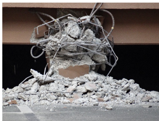
図 8.4.4 4月16日の本震後の状況 (圧壊した柱)
