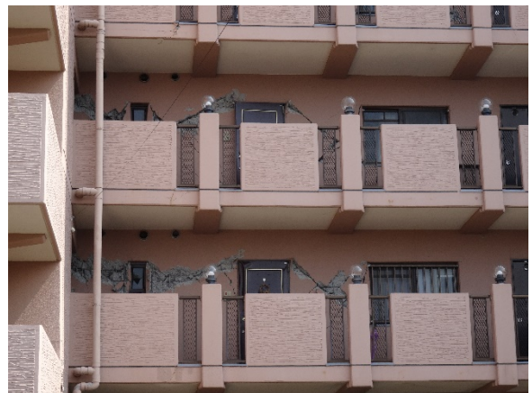
図 8.4.10 4月16日の本震後の状況 (集合住宅の廊下の壁の損傷)
