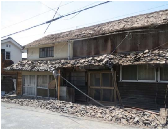
図 8.1.1 4月14日の前震後の益城町の被害 (老朽化した木造住宅の被害)
