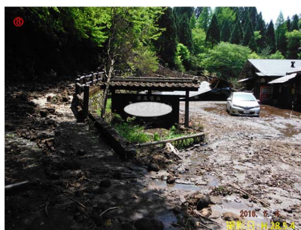
写真4.3.39 垂玉川の上流の斜面崩壊で被災した垂玉温泉
