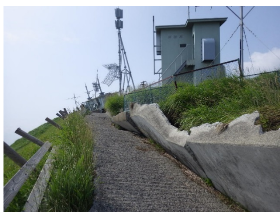
写真 4. 3. 44 山頂付近の擁壁倒壊
