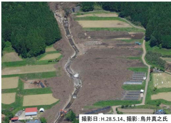
写真 4.4.11 山王谷川の地震時の土石流の氾濫状況
