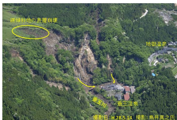
写真4.3.38 垂玉川の上流の斜面崩壊
