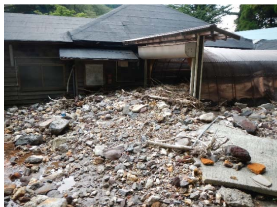
写真 4. 4. 8 地獄温泉内に流れ込んだ土石流の堆積状況
