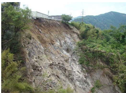
写真 4.3.54 黒川左岸 * コンビニ裏の崖が崩壊、京都大学研究所溶岩層で熱変質を受け灰白色である。
