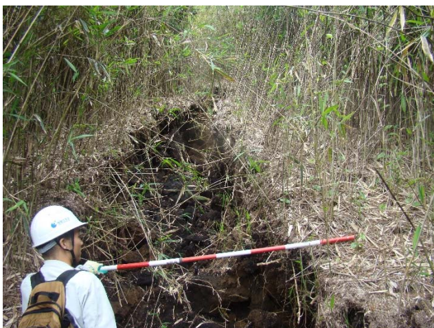
写真 4.3.13 開口亀裂（滑落崖上部斜面）
