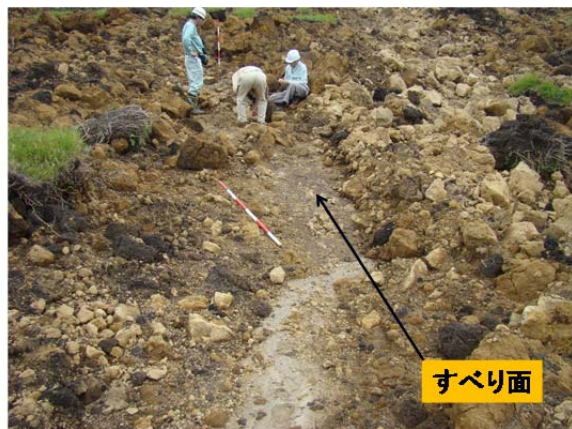
写真 4.3.19 露出した平滑なすべり面
