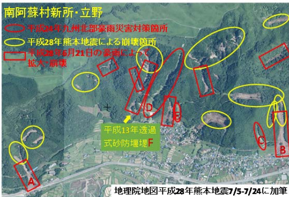
写真 4.4.1 南阿蘇村新所地区の地震及び豪雨後の変状
