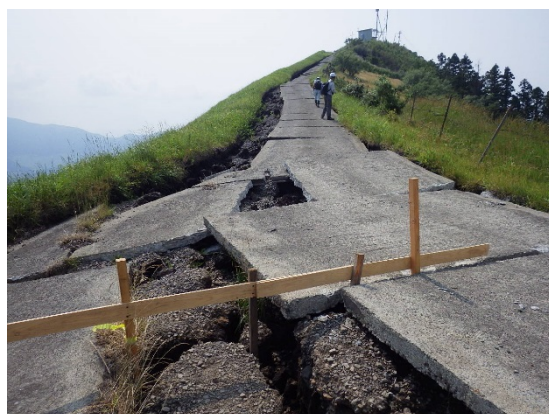
写真 4. 3. 46 通路沿いの地割れ (コンクリート舗装版が左右上下にずれる)
