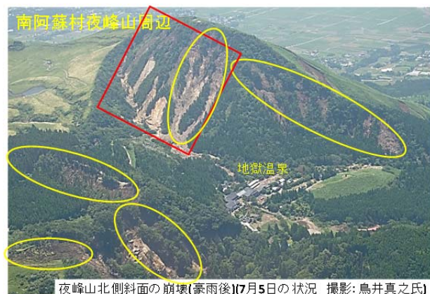
写真 4. 4. 6 夜峰山北側の豪雨後の状況
