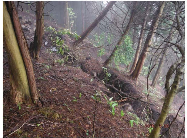
写真 4.4.4 斜面 B の上部周辺に見られた亀裂 (H. 28. 5. 28 撮影)
