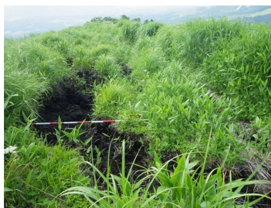
写真 4. 3. 48 山頂部の地割れ（幅約 3.6m）
