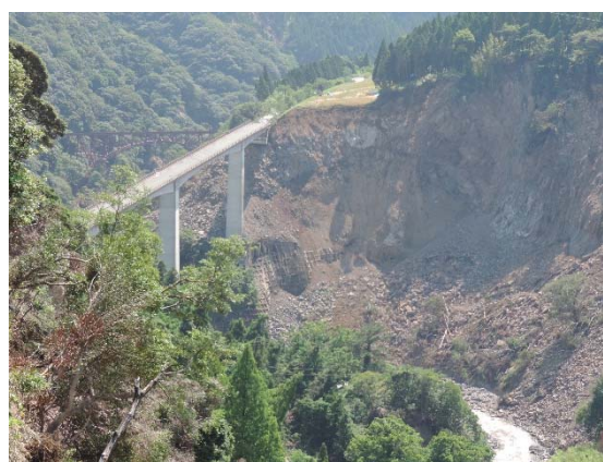
写真 4.3.57 阿蘇長陽大橋付近の崩壊 * 黒川右岸に連続する岩盤崩壊のため橋台基礎が不安定化している。 アプローチ立野溶岩は柱状節理が発達している。上位の赤瀬溶岩はブロック状に破壊が進んでいる。
