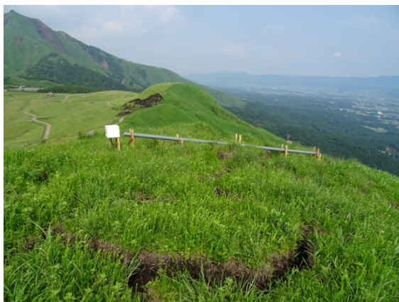
写真 4. 3. 42 崩壊上部斜面の亀裂計測
