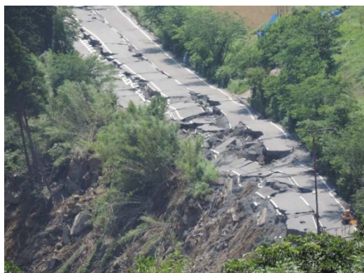
写真 4.3.55 合流点下流の白川右岸 * 地震動による岩盤崩壊で引張り破壊が進む村道。この先に阿蘇長陽大橋がある。
