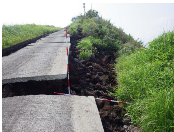
写真 4. 3. 47 北側斜面崩壊頭部
