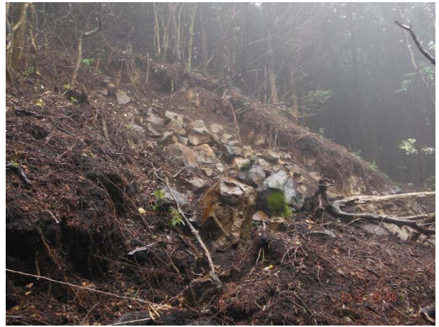
写真 4.4.3 斜面 B の地震後の上部の状況 (H. 28. 5. 28 撮影)
