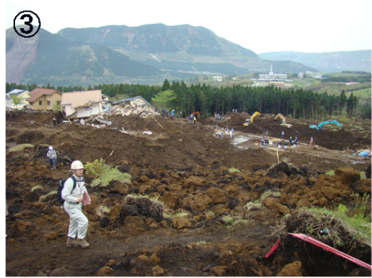
写真 4.3.17 高野台の被災状況
