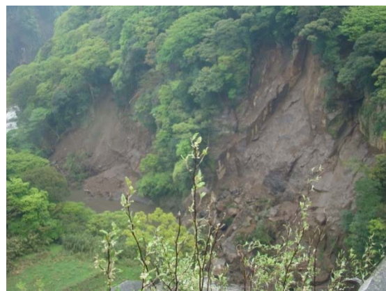
写真 4.3.56 合流点付近の白川右岸 * 先阿蘇火山岩類の安山岩溶岩の不連続面からの平面すべり、大規模な剥離型の岩盤崩壊。
