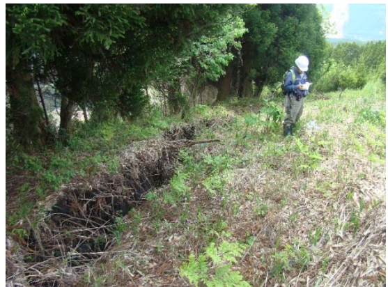
写真 4.3.28 頂きの平坦面の開口亀裂
