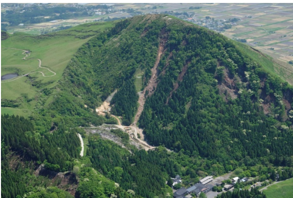
写真 4.3.51 夜峰山北側斜面の崩壊状況 (地震後(5月14日))(撮影：鳥井真之氏)
