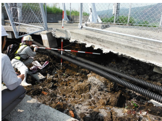
写真 4. 3. 45 深礎杭基礎で電波塔の傾動なし
