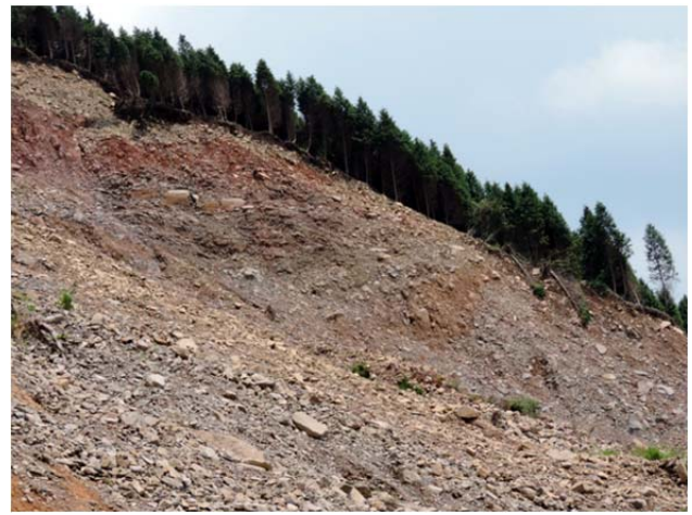
写真 4.3.9 崩壊右側部に見られる安山岩層のクリープ変形
