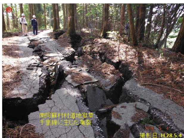
写真4.3.36 村道地獄草千里線の亀裂（C-1）
