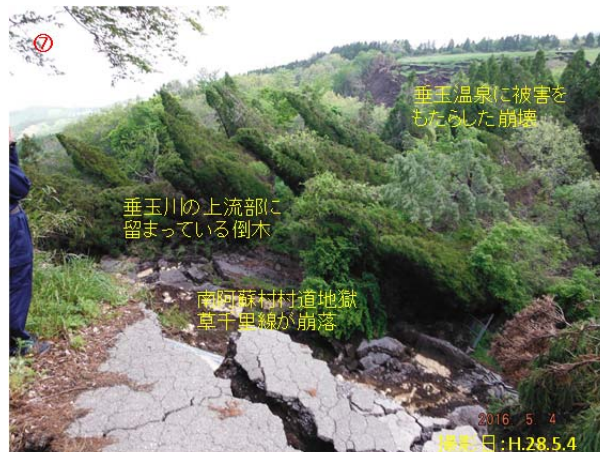
写真4.3.37 村道地獄草千里線の崩落（C-2）
