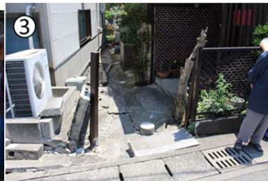
図 3. A. 10 松尾・高橋・上代地区における液状化被害
