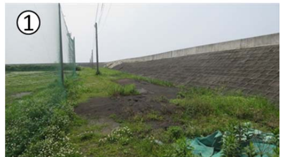
図 3. A. 10 松尾・高橋・上代地区における液状化被害
