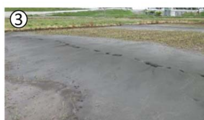
図 3. A. 12 犬渕地区・御幸木部地区における液状化被害
