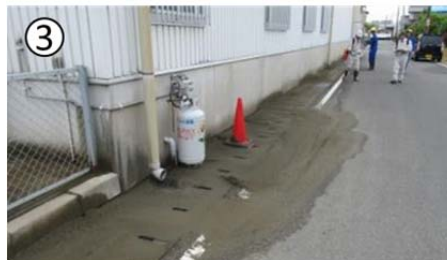
図 3. A. 13 上島・鯉地区における液状化被害
