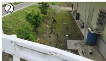
図 3. A. 14 秋津町秋田地区における液状化被害
