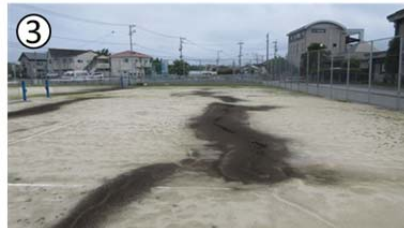
図 3. A. 5 土河原地区, 砂原・孫代地区における液状化被害
