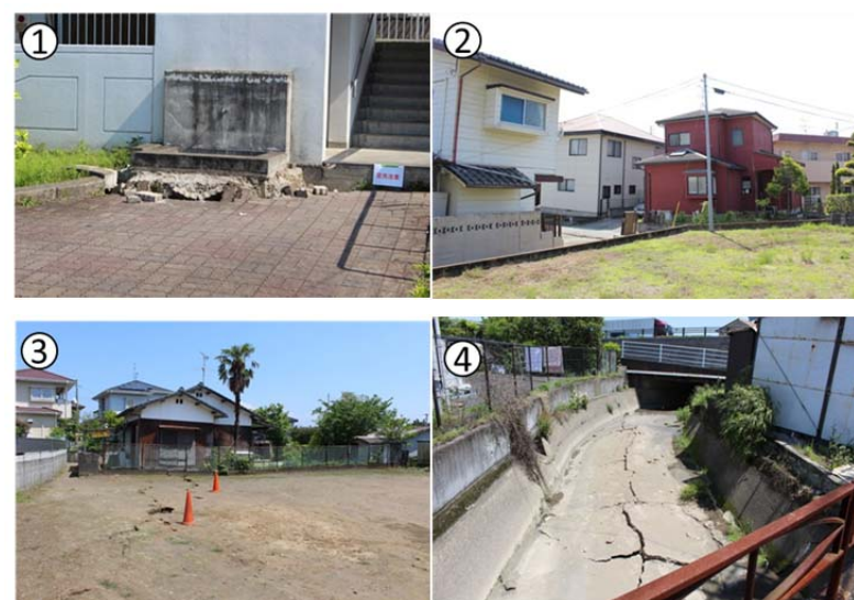
図 3. A. 3 八幡地区における液状化被害
