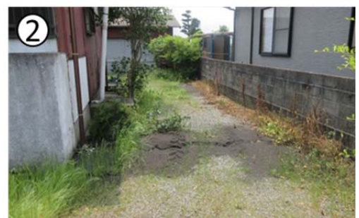
図 3. A. 5 土河原地区, 砂原・孫代地区における液状化被害
