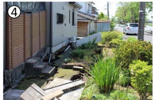
図 3. A. 13 上島・鯉地区における液状化被害
