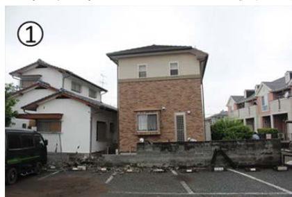
図 3. A. 14 秋津町秋田地区における液状化被害
