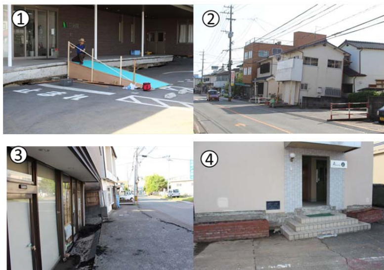
図 3. A. 1 近見・刈草地区における液状化被害
