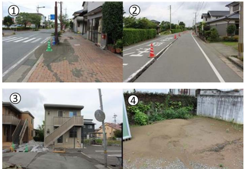
図 3. A. 4 富合・川尻地区における液状化被害
