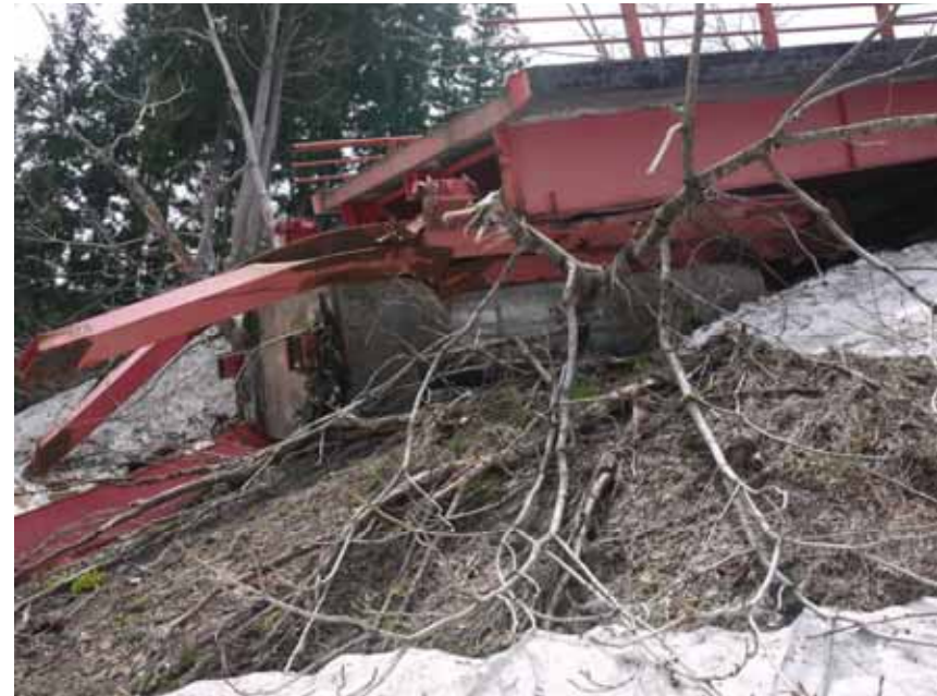
写真-5 青倉集落側橋脚部分(右側が部落)
