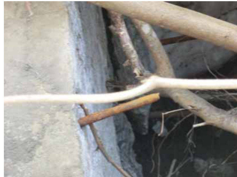
写真-7 橋脚の破断面
