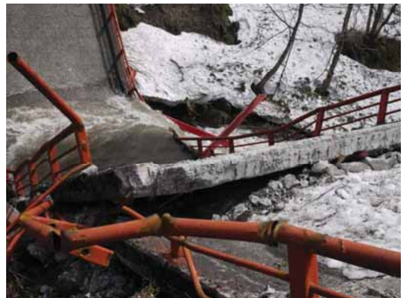
写真-10 青倉集落側から撮影
