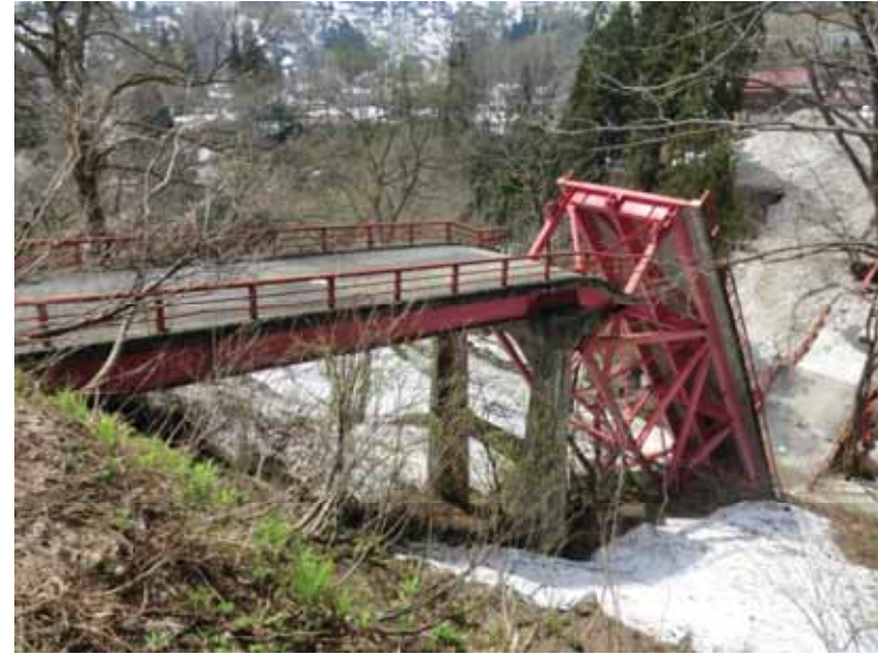
写真-11 国道側(栄大橋側)から撮影
