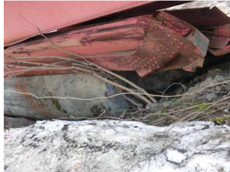
写真-7 橋脚の破断面
