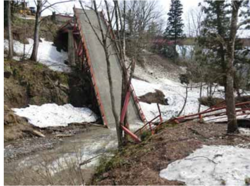
写真-9 青倉集落側から撮影
