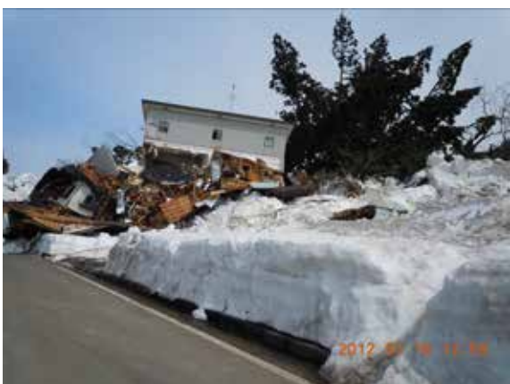
写真-17 被災家屋 ( ) 土塊先端に乗せられて移動 ( 約 60cm / h )
