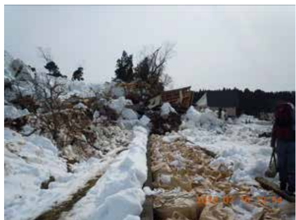
写真-18 水利 ( から先端右側 ) 水路に樹脂管を入れ土嚢で保護
