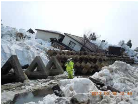
写真-15 被災家屋とテトラポッド ( ) テトラポッドは地方整備局備蓄分
