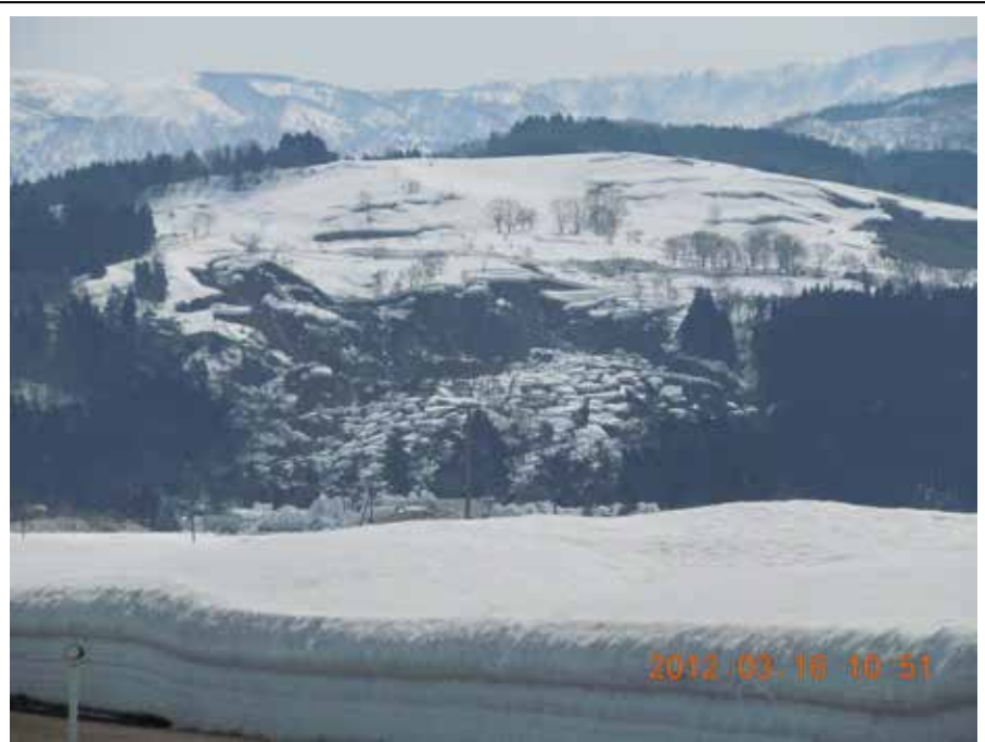
写真-7 被災地遠景（崩壊斜面源頭部が見える）
