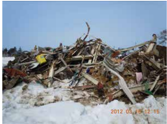
写真-16 倉庫と思われる被災家屋 ( ) 巻き込んだ時の破壊力はすさまじい
