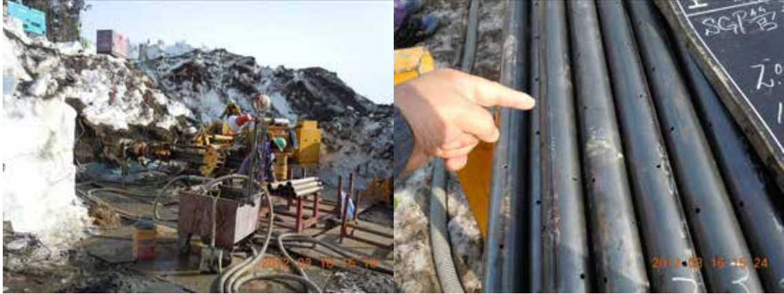
写真-22 排水ボーリング ( ) 計画長 80m (側方)
