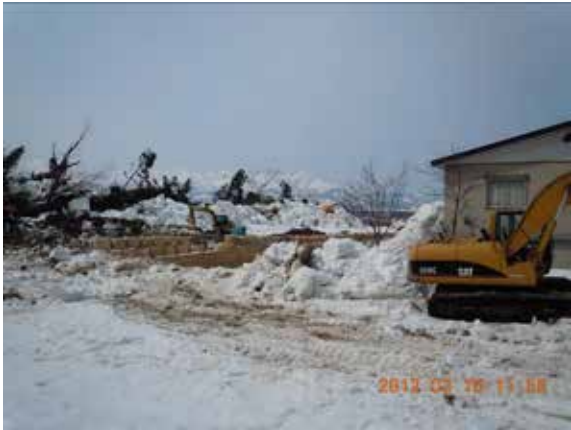
写真-8 拡大防止土嚢 ( )
