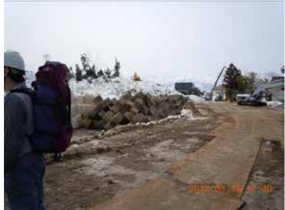
写真-14 テトラポッドで抑止 ( 下流 ) テトラポッドは地方整備局備蓄分
