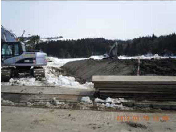
写真-19 建設中の土堤（側） 一日の調査間で5 mほど伸びた
