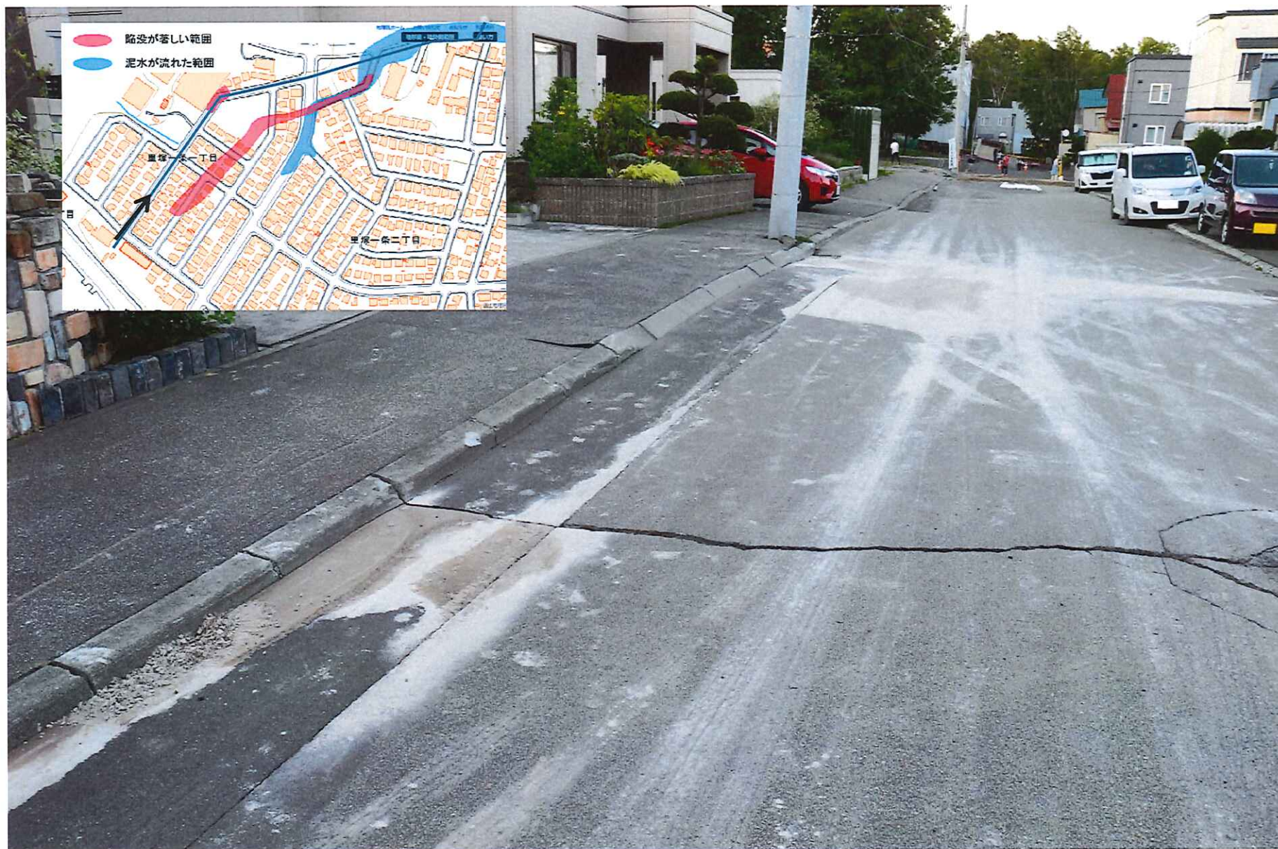
液状化による噴砂の跡(陥没エリア周辺では、最上部側のこの辺りでのみ見られた)
