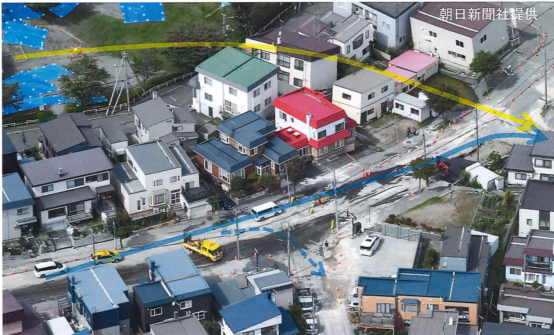
札幌市清田区里塚1条の 被害地域の一部. 上部が土砂流出による陥没. 下部は水道管破裂.
