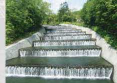
奥沢水源地下水道施設
