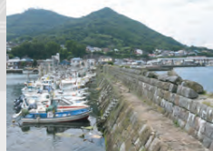
函館港改良工事
