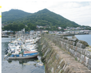
3. 函館港改良工事
