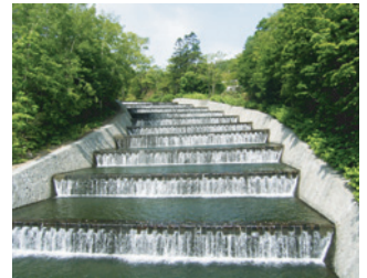
2. 奥沢水源地下水道施設
