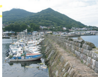
3. 函館港改良工事
