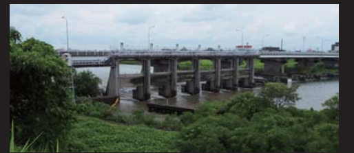
庄内川に建造されているこの頭首工に誘導された水が元坎樋門へ流れ込む。
