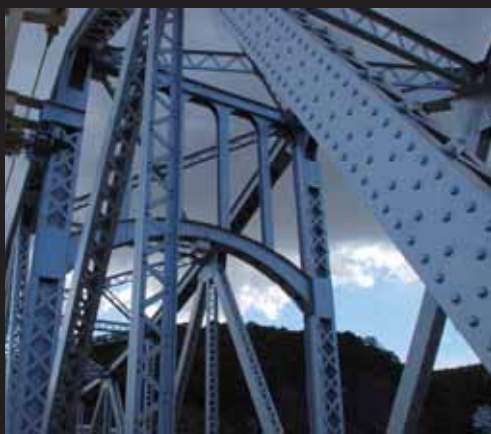
カンチレバートラスの主塔部分
