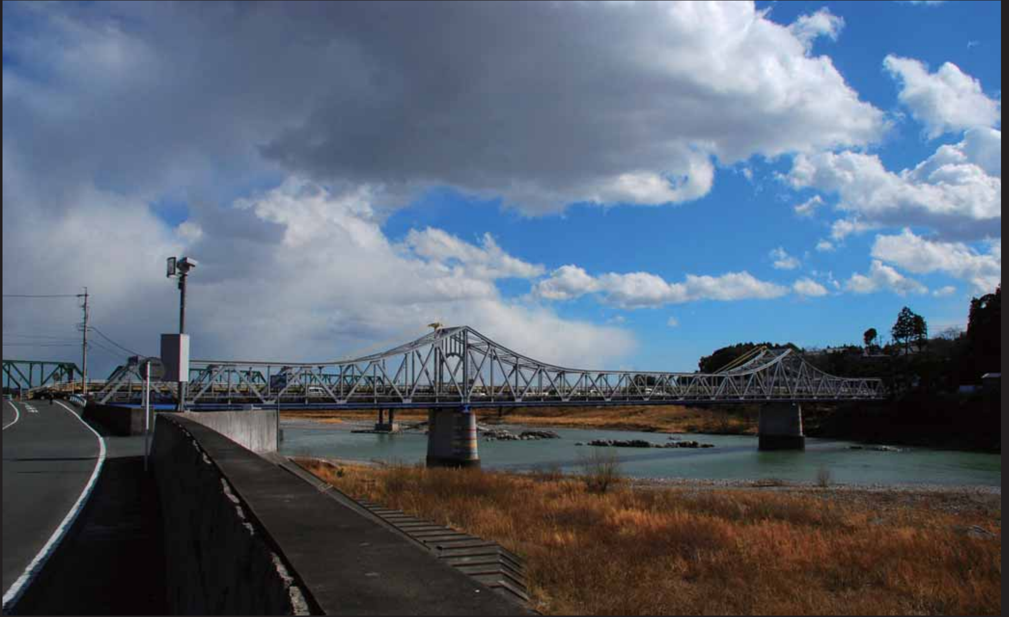
上流左岸から眺める鹿島橋
