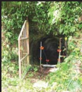
▲トンネルの横穴。施工上、管理上必要だった。
