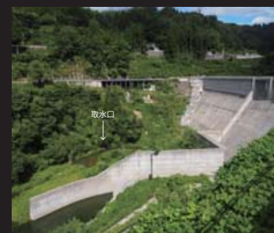
辰巳ダム施設に開まれて遺された辰巳用水取水口
