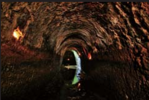
▲取水された水は、手掘りの隧道（トンネル）を流れる。
