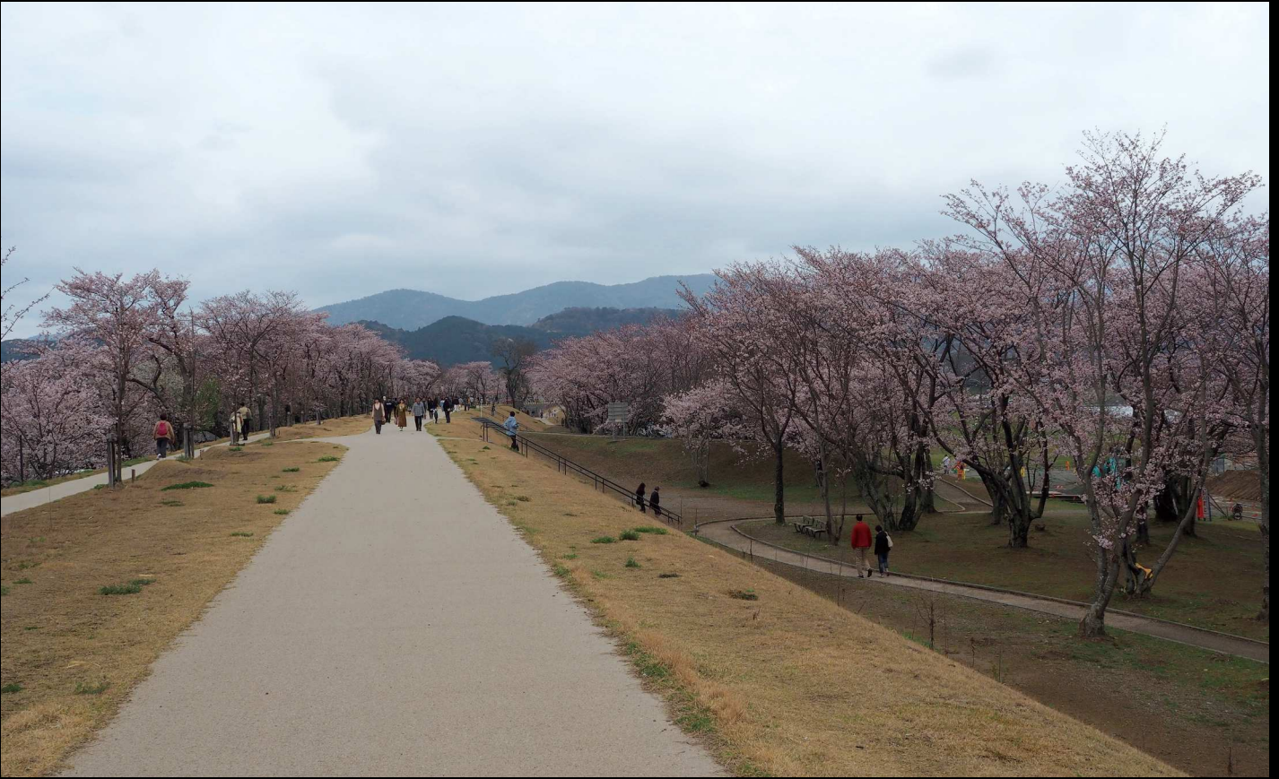
本堤とそこから突き出した周防守堤を下流側から見る
