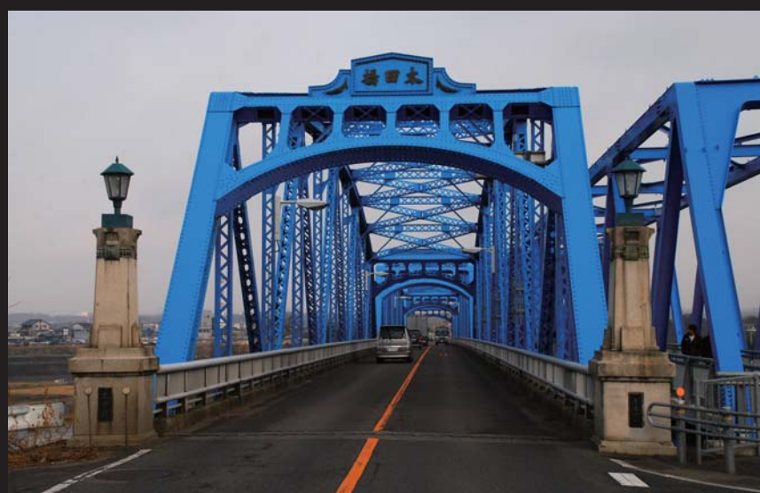
可見市側から美濃加茂市方向を見る
