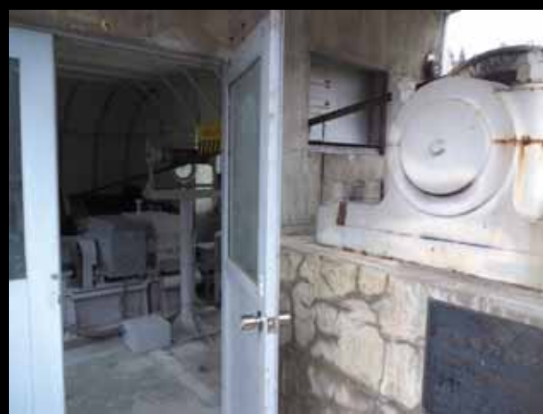
R型ピア上部の室内には巻揚機が設置されている。これによりワイヤーロープを操作し鋼製ドラムを回転させながら上げ下げ（輾動）する仕組みになっている。巻揚機の動力は、現代のものに取り換えられているが、機構はそのまま使われている。
