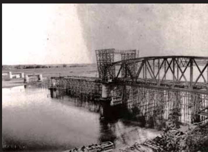
建設中の様子
