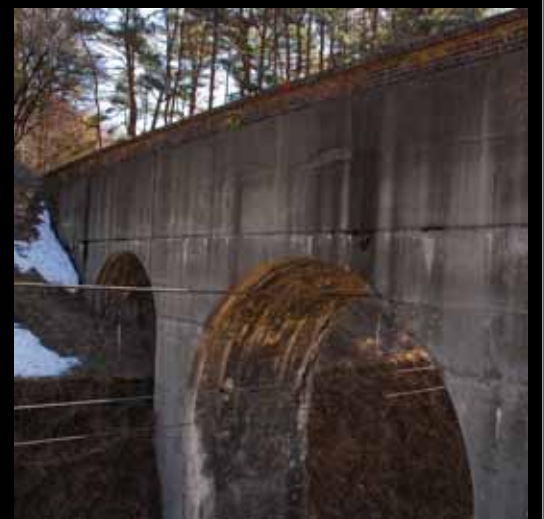
構造物の北側は土地柄凍結融解により痛み、全面的にコンクリートで補修されており、煉瓦の構造は見えない。
