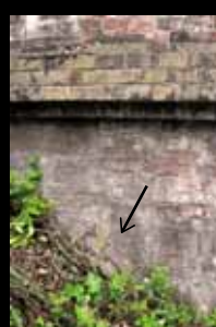
左 今では 3 連のアーチに見えるが、実は 5 連のアーチで作られている。隠れたアーチの一部が幸うじて確認できる。(写真：小西純一)
