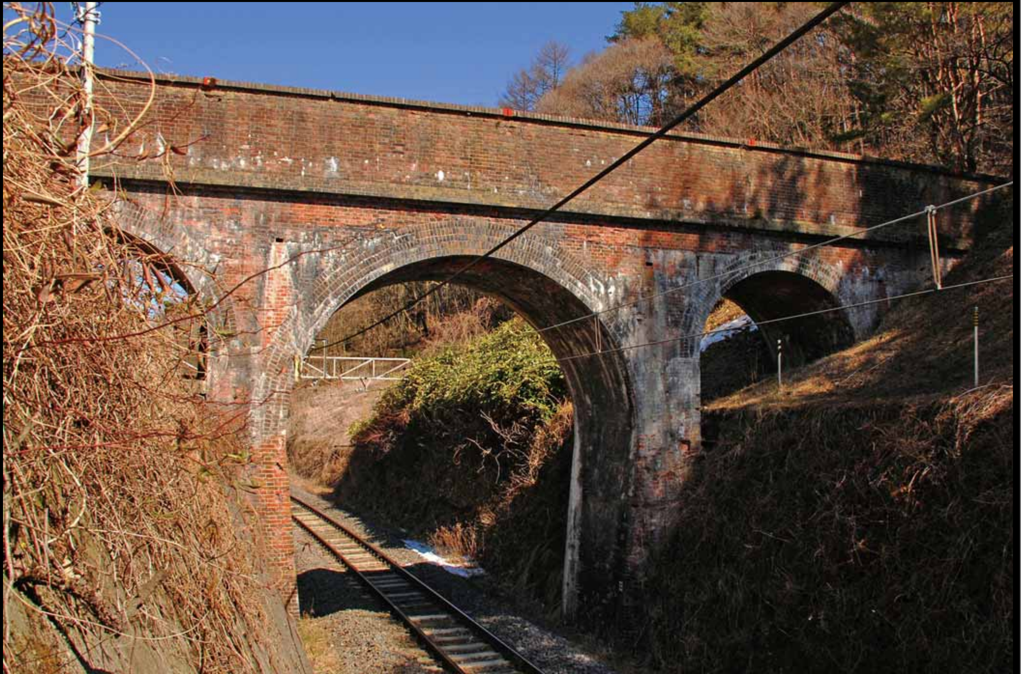
風雪に耐えてきた味わい深い煉瓦造の水路橋が鉄道の線路を跨ぐ
