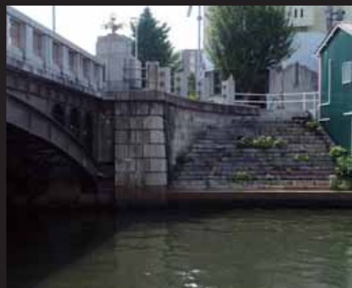
アーチ上部は力を伝える部材の他に、小さなアーチと渦巻の意匠をさりげなく施された飾り板で覆われる。アーチの圧縮力を支えるために重厚に造られた橋梁端部の両脇は、荷揚げのできる花崗岩の階段護岸がデザインされている。
