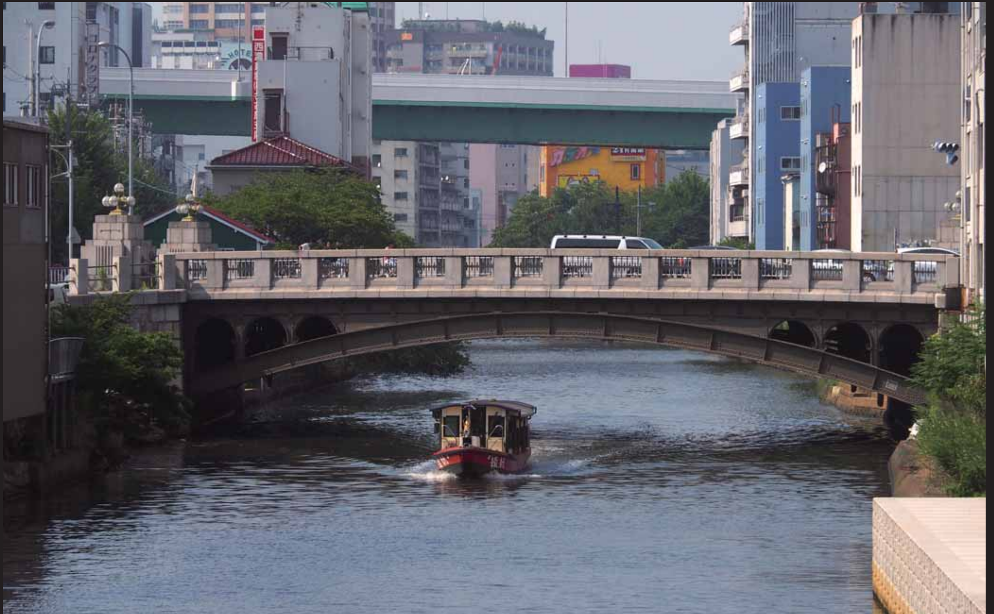
下流側から見る岩井橋
