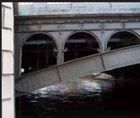
アーチ上部は力を伝える部材の他に、小さなアーチと渦巻の意匠をさりげなく施された飾り板で覆われる。アーチの圧縮力を支えるために重厚に造られた橋梁端部の両脇は、荷揚げのできる花崗岩の階段護岸がデザインされている。
