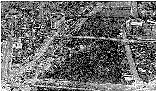
写真—4.6 都営地下鉄隅田川横断工事全景
