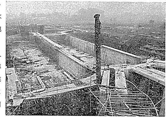
写真-2.5 利根導水路水道専用水路沈砂池
