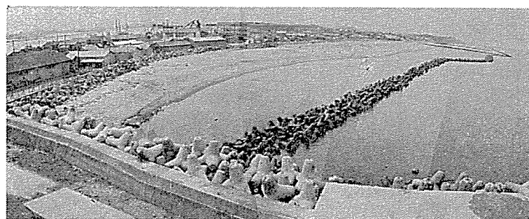
写真—2.26 新潟地盤沈下対策事業実施状況
